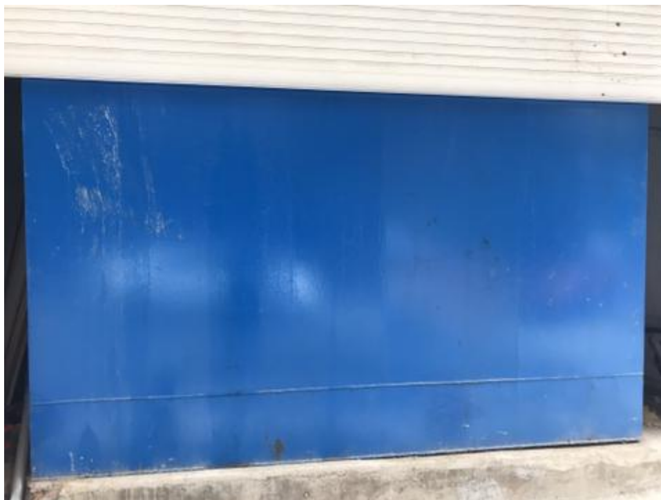
图 4-2 生产废水处理设施
